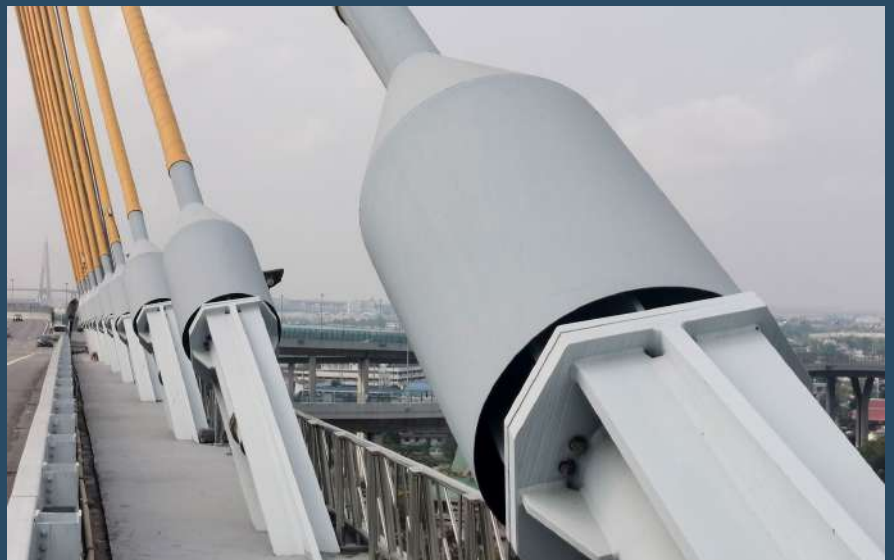
Barandillas del puente Bhumibol – Tailandia
