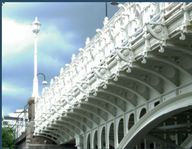
Puente Haussman de Oslo – Noruega
