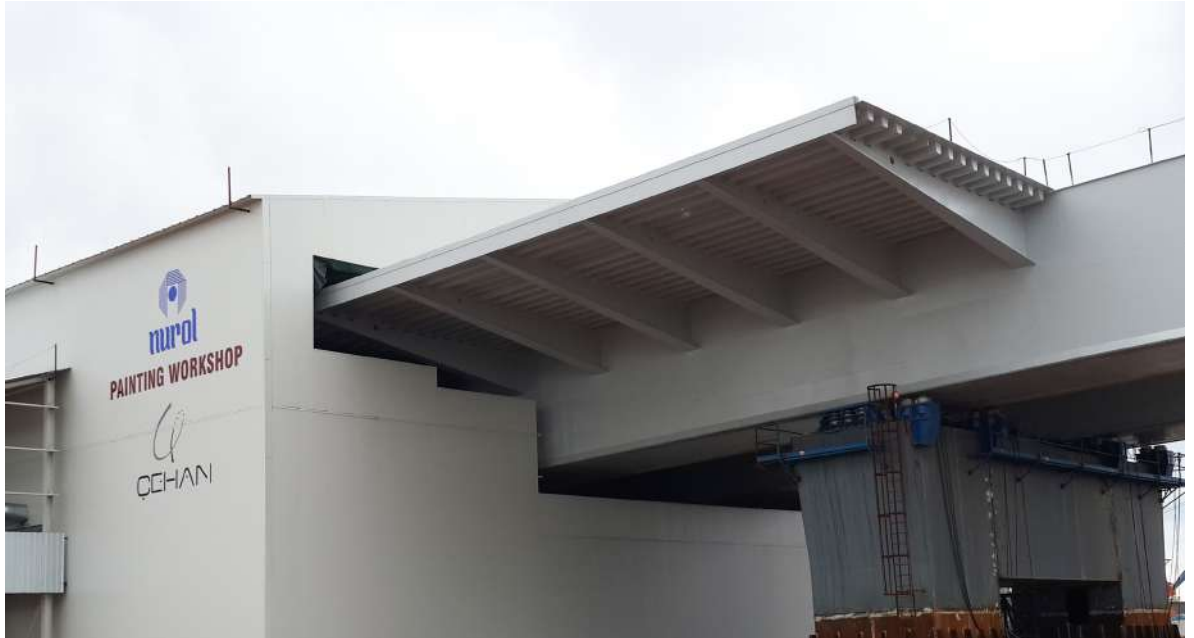
Viaducto del Puente de la Bahía de Izmit – Turquía
