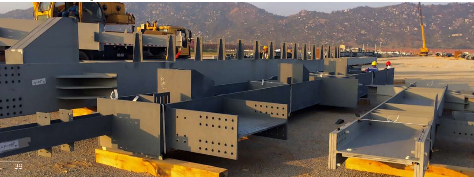
Central eléctrica de Lufeng – China
