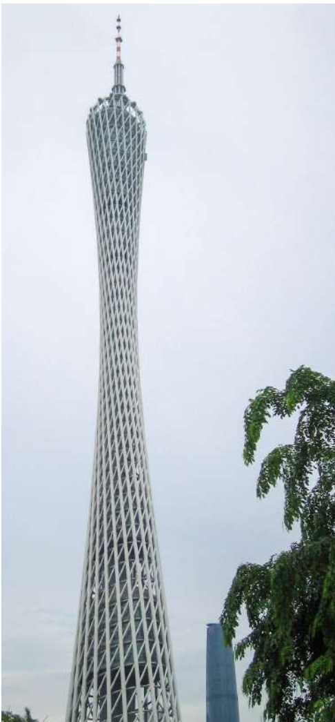
Torre de Televisión de Guangzhou – China
