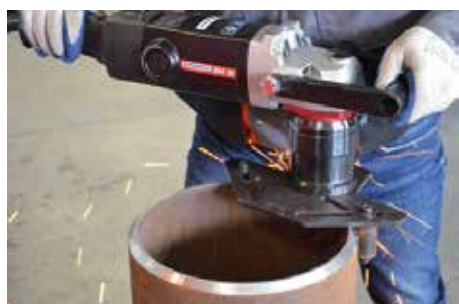
Biselado de tubería
