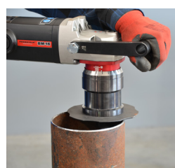
Biselado de tubería
