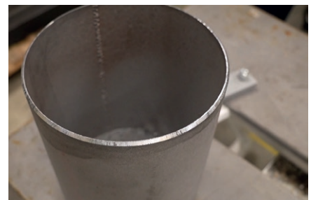
Biselado de tubería
