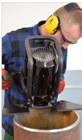
Biselado de tuberías
